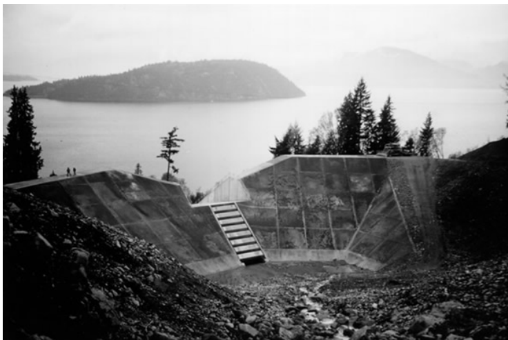
Figure 25 : Barrage de rétention. Vue de la trajectoire d'une coulée de débris le long du ruisseau Charles, à la baie Howe (Colombie-Britannique), vers un ouvrage de rétention des coulées de débris construit au milieu des années 1980 afin de protéger des résidences à Strachan Creek. L'ouvrage a été conçu pour retenir une éventuelle coulée de débris de 29 000 mètres cubes.
