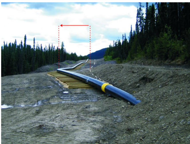
Figure 4 : Reptation. Le mouvement lent vers le bas de débris d'érosion a déplacé (flèche) un gazoduc dans le nord de la Colombie-Britannique. La position initiale du pipeline est indiquée par une ligne blanche tiretée. Le pipeline a été placé sur des pièces de bois pour lui permettre de s'ajuster au mouvement continu de la pente.
