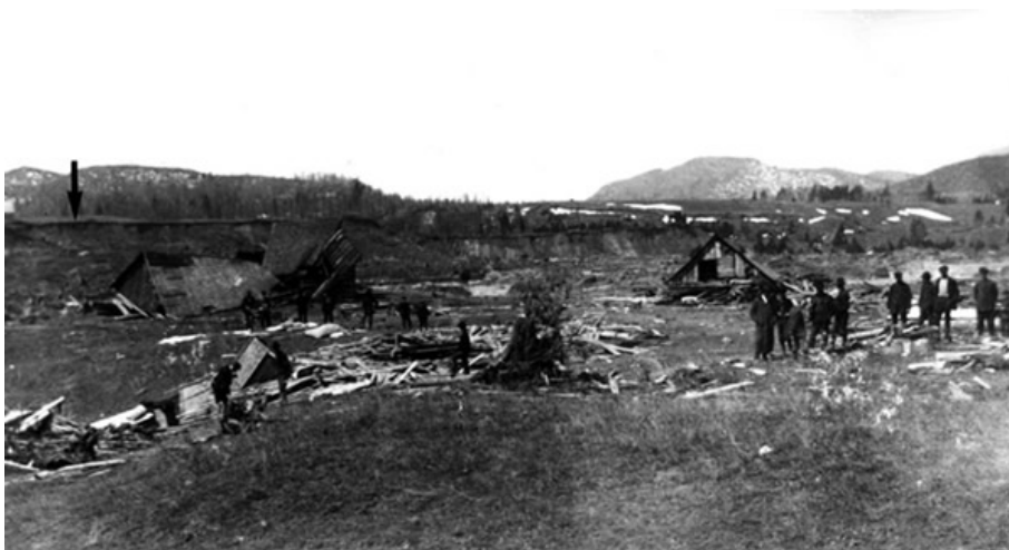
Figure 19 : Glissement de terrain à Notre-Dame-de-la-Salette, Québec. Photographie contemporaine de la destruction de Notre-Dame-de-la-Salette, dans l'ouest du Québec, montrant les effets d'une vague provoquée par un glissement de terrain sur des bâtiments en bois situés sur la rive est de la rivière du Lièvre, en avril 1908. La flèche indique l'escarpement du glissement de terrain sur la rive ouest de la rivière.
